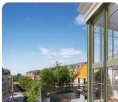
Logements et commerces sur un ancien site industriel au Blanc-Mesnil (93)
