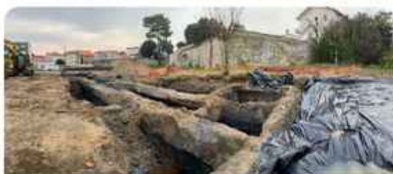
Chantier de Royan (17)
