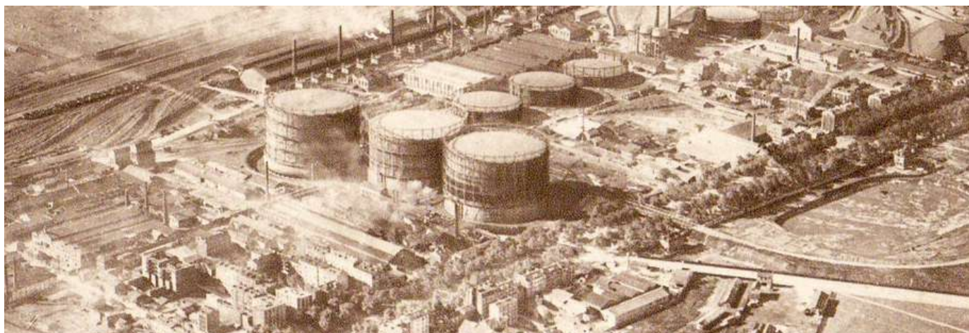
Ancienne usine à gaz d'Engie
