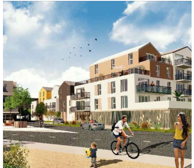
Résidence Services Séniors à Chartres (28) Reconversion d'une usine de gaz
