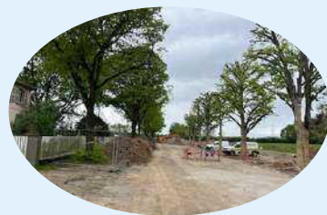
Ecoparc de la Basse Zorn (67): Impact positif de la création de noues et de tranchées d'infiltration pour restaurer le cycle naturel de l'eau
