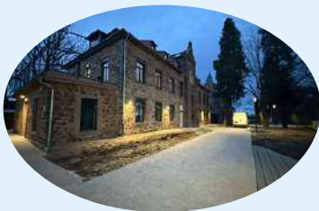
Hoerdt (67) : Rénovation de 11 bâtiments historiques très dégradés en bureaux appréciés pour leur caractère patrimonial
