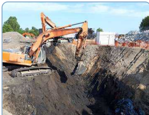
Dépollution d'une cuve de goudrons
