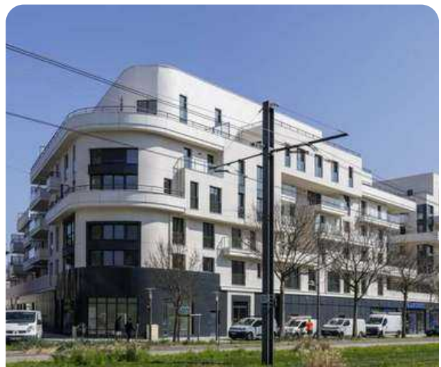
Le magasin Leclerc a déménagé au rez de chaussée du lot 2 pendant 2 ans
