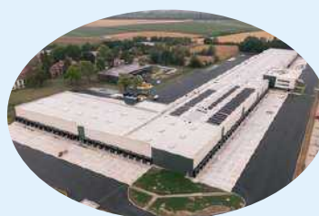
14 entreprises installées - 1000 emplois - Ecoparc de la Basse Zorn à Hoerdtt (67)
