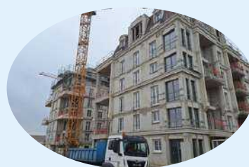
150 logements sociaux construits au Blanc Mesnil (93)
